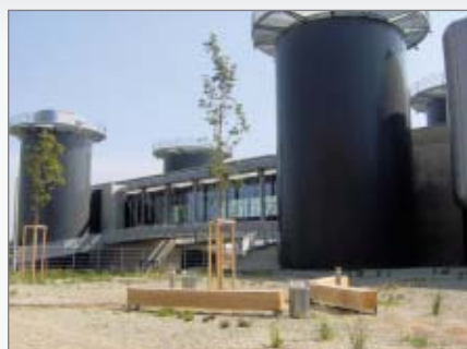
08/2007 Předmostí a pilíře energocentra
