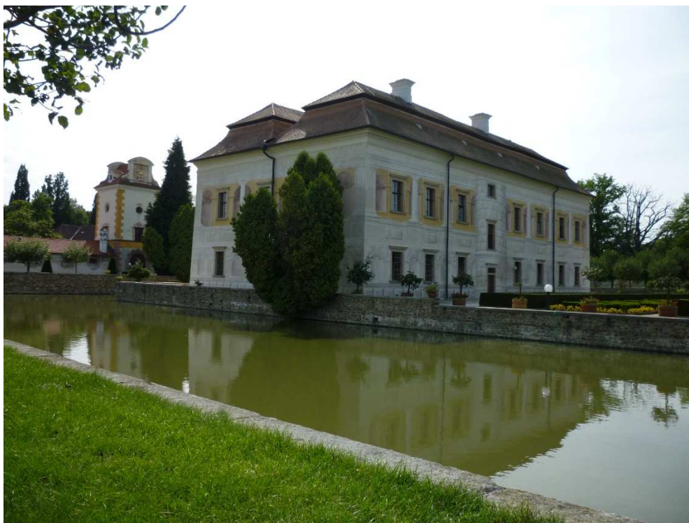
60. Pohled na ústřední objekt a vstupní průjezdní věž vily Kratochvíle.
